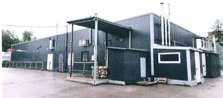
Дворовой фасад (в осях Б-А)
