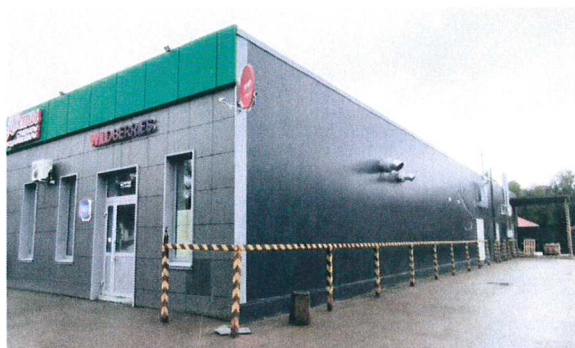
Дворовой фасад (в осях Б-А)
